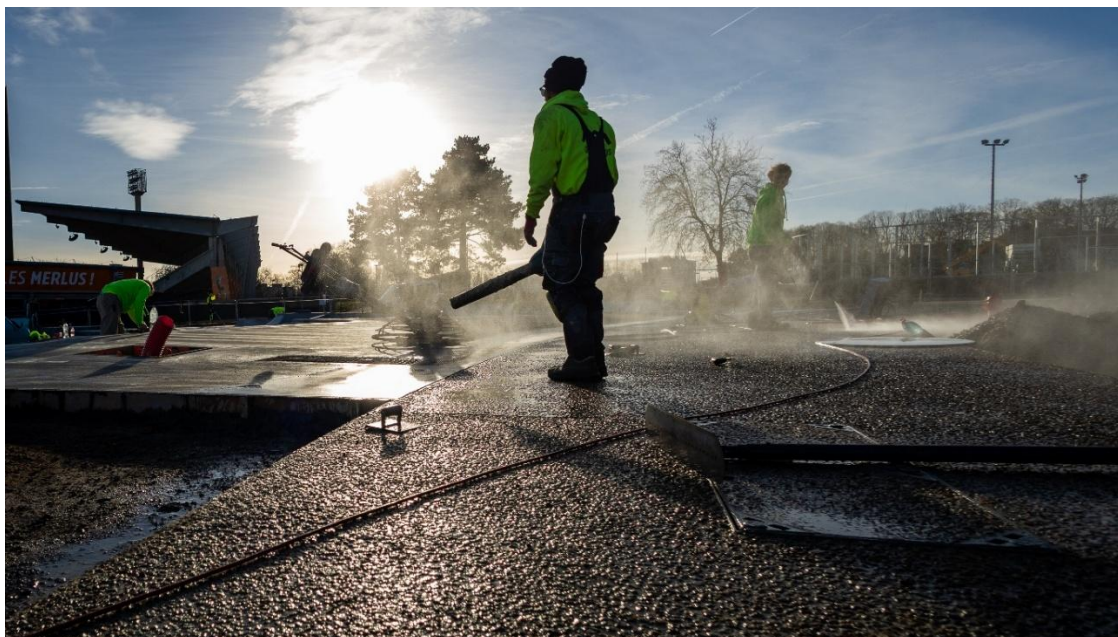
Parc du Moustoir - Travaux de revêtement ©ButterProduction
