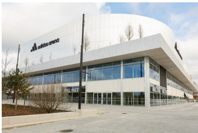
Photo n° 1 : "Aréna Porte de la Chapelle (Adidas Aréna)"
