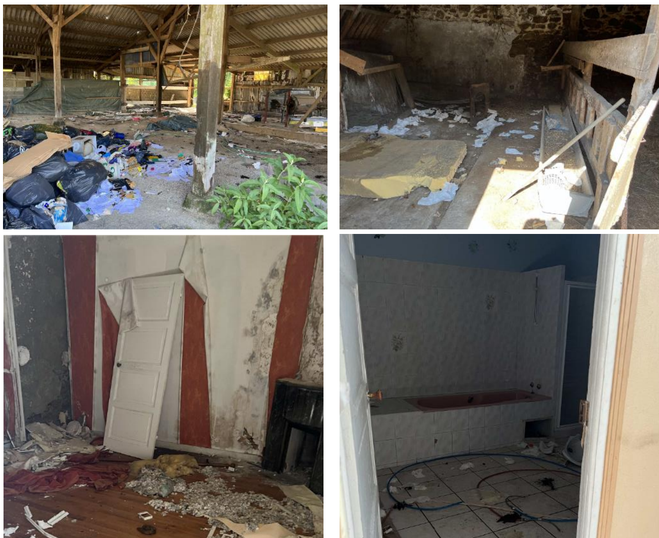
Figure 63 - Etat des bâtiments avant démolition
