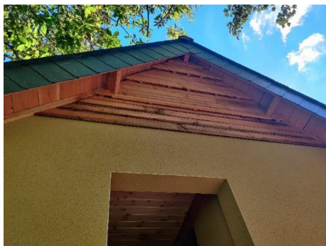
Figure 68 : Exemple de bardage aménagé (Biotope)
