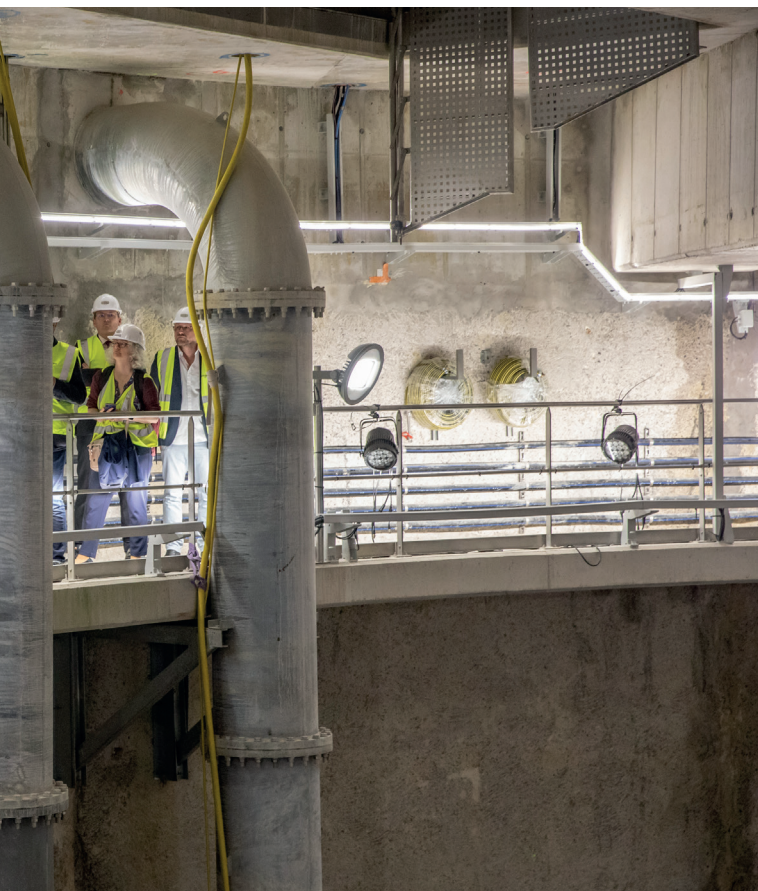
Inauguration du bassin de rétention départemental du ru Saint-Baudille © Nicolas MOULARD / Département de la Seine-Saint-Denis
