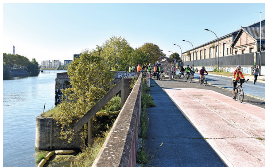
Quai Henri Pourchassé, Ivry-sur-Seine
