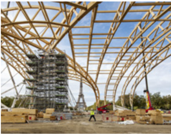
Chantier du Grand Palais éphémère.
