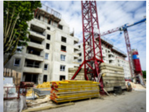
La phase 1 de la ZAC Maison Blanche à Neuilly-sur-Marne sera achevée à l'été prochain.
