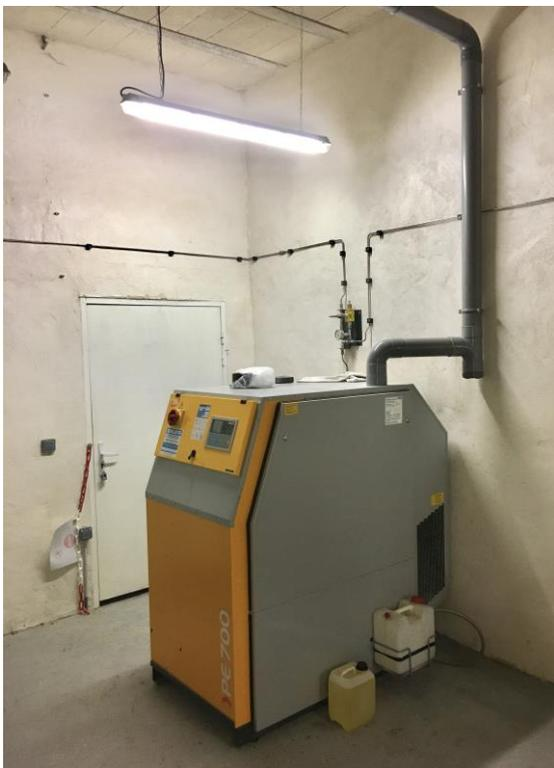
*Le compresseur permet de remplir les bouteilles : on remarquera la prise d'air qui part vers le haut et qui doit garantir un chargement en air non vicié.*
