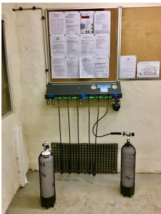
*La rampe de gonflage permet de remplir plusieurs bouteilles en même temps et de séparer l'espace de gonflage du compresseur.*
