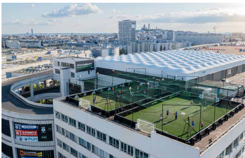
Terrains de foot à 5 à Paris (18 e ) dont six couverts par SMC2 (structure bois, membrane textile) à la place de parking sur le toit d'un bâtiment logistique.
