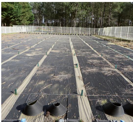
Figure 22 : Capteurs non vitrés posés à même le sol
