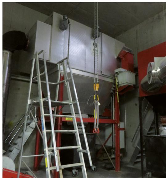
Figure 18 : Electrofiltre (Piscine Mallarmé - Besançon)
