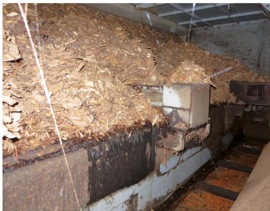
Figure 9 : Plaquettes forestières – système de transfert par convoyeur de reprise à bandes transporteuses (Centre aquatique du Pays de Morlaix-29)
