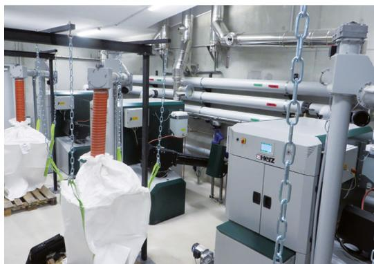
Figure 12 : Chaufferie bois avec 3 chaudières bois de puissance unitaire 150 kW - (piscine intercommunale de Morbier - 39)
