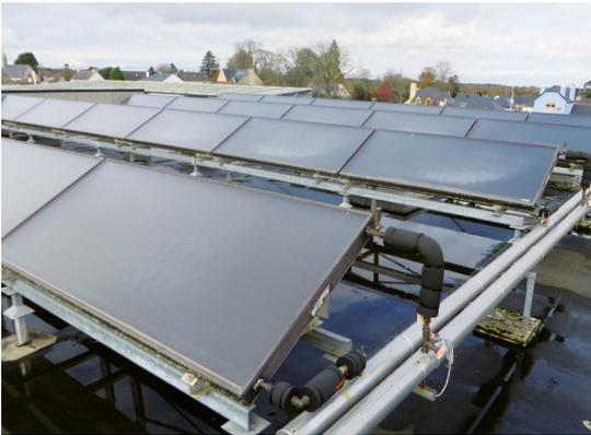
Figure 19 : Capteurs plans en toiture terrasse
